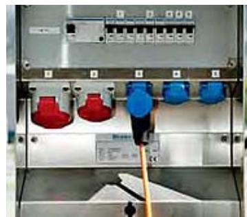
Stromtankstelle mit verschiedenen Anschlussmöglichkeiten
